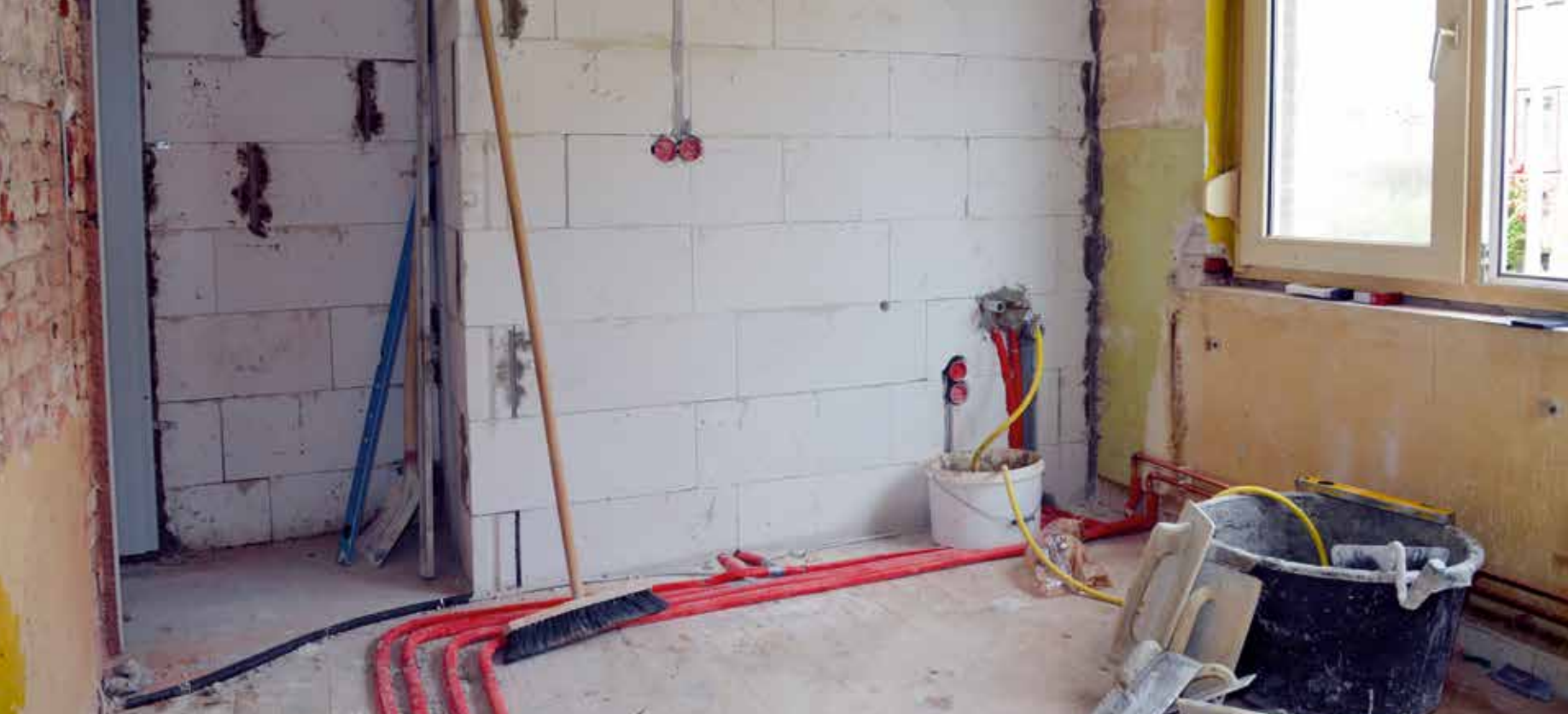
Durch das Versetzen einer Wand wird das Badezimmer der Wohnung im Halligenweg geräumiger.
