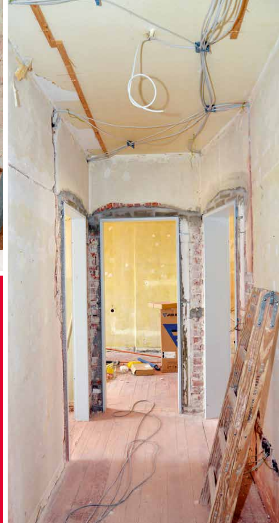
Für die grundlegende Modernisierung werden Wände, Fußböden und Leitungen vollständig freigelegt.
